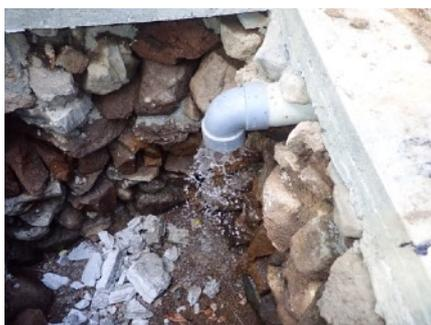
り、原因究明?配管が少し傾いているために洗面台下のパッキングがゆがんでいるようです。そこで、配管を傾けながらも一度締め直したら、水漏れが止まりました。
